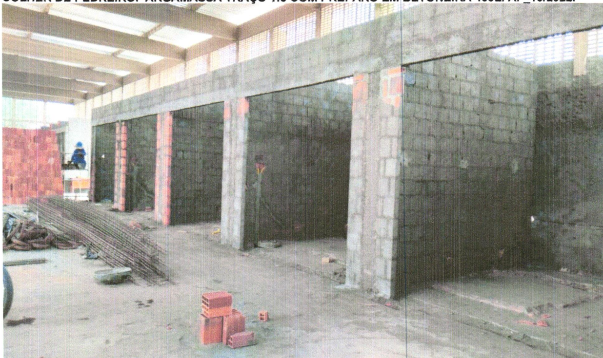
FOTO 34 - CHAPISCO APLICADO EM ALVENARIAS E ESTRUTURAS DE CONCRETO INTERNAS, COM COLHER DE PEDREIRO. ARGAMASSA TRAÇO 1:3 COM PREPARO EM BETONEIRA 400L. AF_10/2022.
