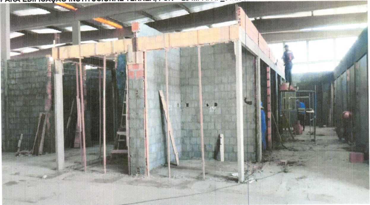
FOTO 30 - (COMPOSIÇÃO REPRESENTATIVA) EXECUÇÃO DE ESTRUTURAS DE CONCRETO ARMADO, PARA EDIFICAÇÃO INSTITUCIONAL TÉRREA, FCK = 25 MPA. AF_01/2017
