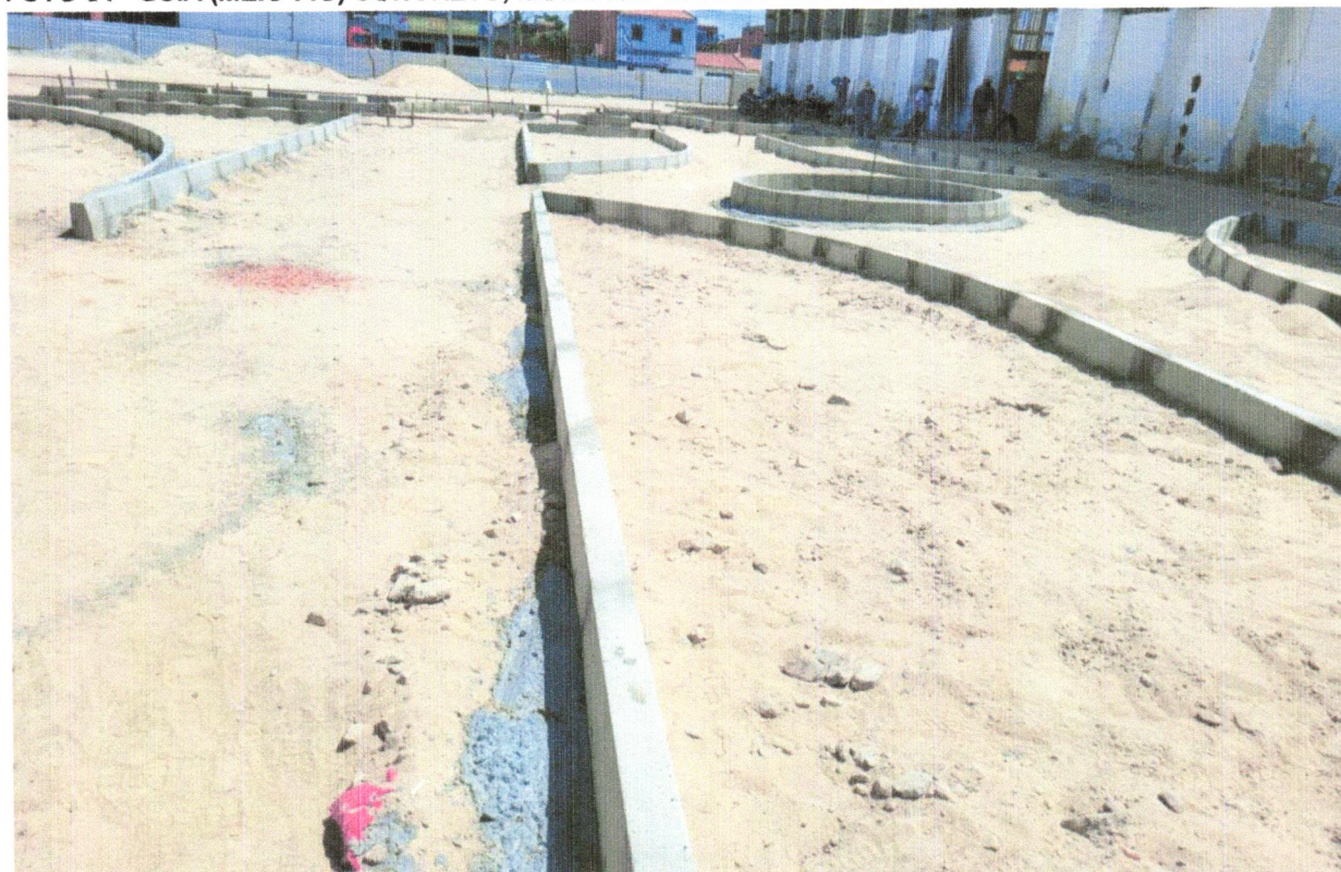
FOTO 64 - GUIA (MEIO-FIO) CONCRETO, MOLDADA IN LOCO EM TRECHO RETO COM
