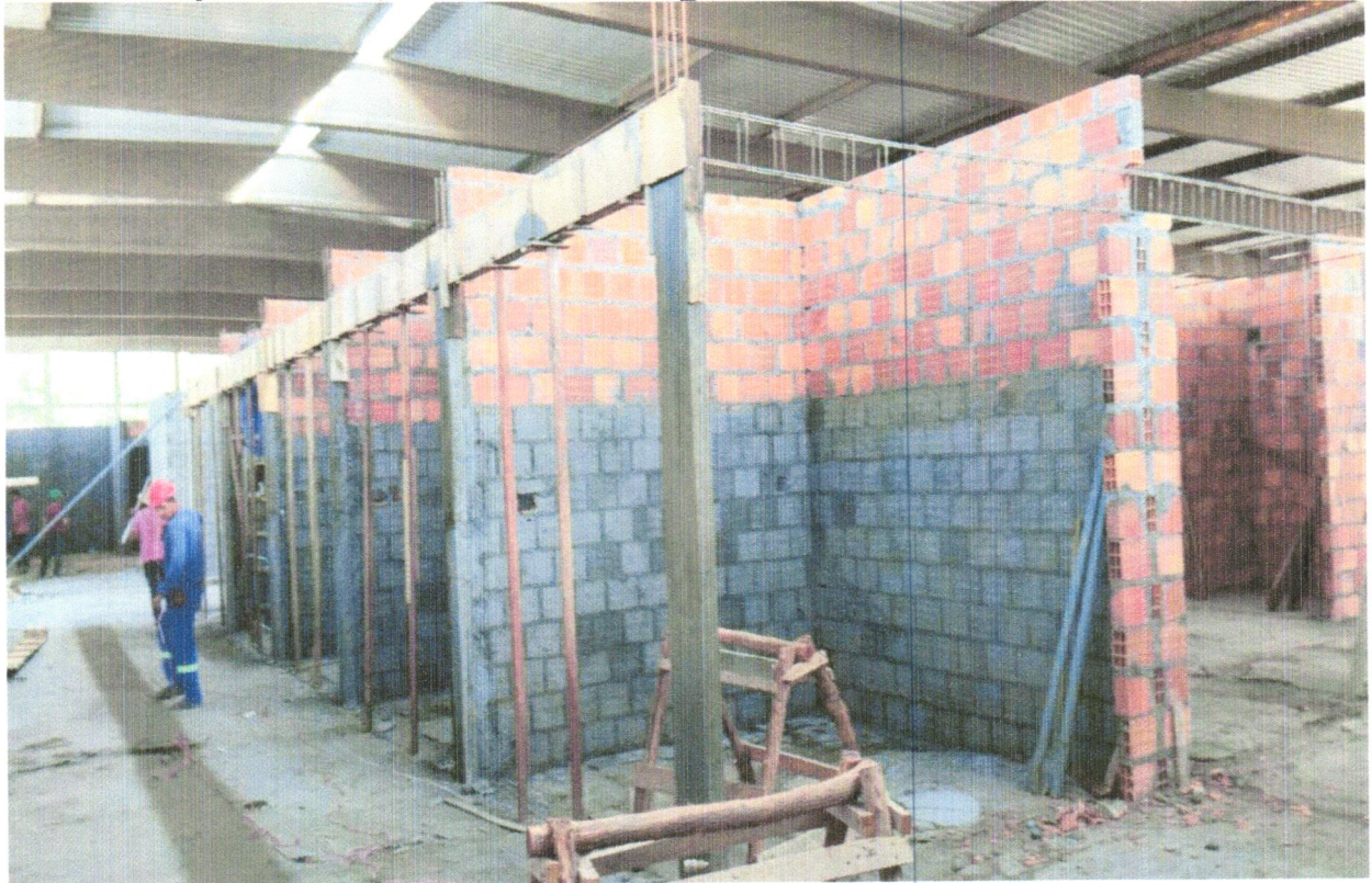
FOTO 26 - (COMPOSIÇÃO REPRESENTATIVA) EXECUÇÃO DE ESTRUTURAS DE CONCRETO ARMADO, PARA EDIFICAÇÃO INSTITUCIONAL TÉRREA, FCK = 25 MPA. AF_01/2017
