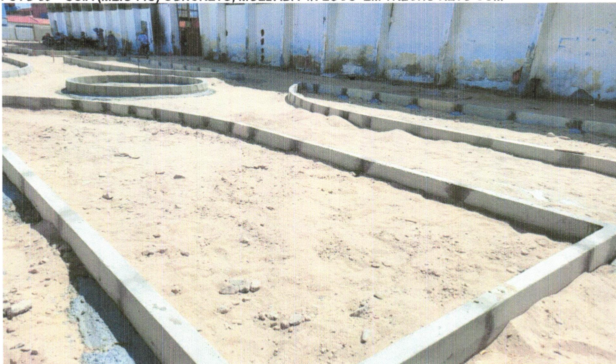
FOTO 64 - GUIA (MEIO-FIO) CONCRETO, MOLDADA IN LOCO EM TRECHO RETO COM
