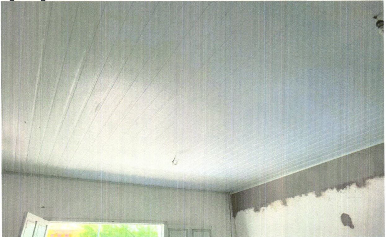
FOTO 54 - FORRO DE PVC, LISO, PARA AMBIENTES COMERCIAIS, INCLUSIVE ESTRUTURA DE FIXAÇÃO. AF_05/2017_PS
