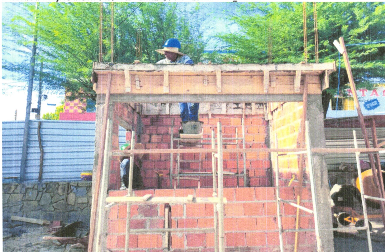
FOTO 58 - (COMPOSIÇÃO REPRESENTATIVA) EXECUÇÃO DE ESTRUTURAS DE CONCRETO ARMADO, PARA EDIFICAÇÃO INSTITUCIONAL TÉRREA, FCK = 25 MPA. AF_01/2017
